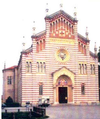
La chiesa di Piazzola sul Brenta
