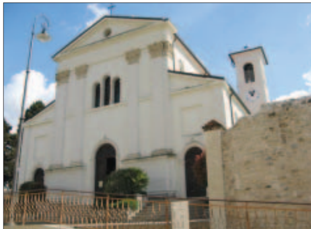
Attuale facciata della Chiesa (Foto A.Mattiusi)
